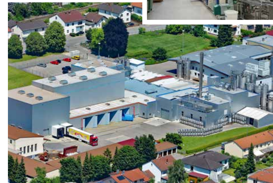
frischli hat mit dem Bau des neuen Gebäudes und der Optimierung des Regallagers den Grundstein für die Zukunft gelegt.
