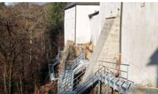
Die Konstruktion am steilen Abhang.
