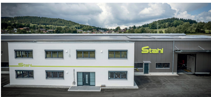
Das neue Gebäude am Standort Geiersthal bietet optimale Bedingungen. Im Lager steht alles für den speziellen Angebotsbereich von Küche bis Seziertisch.
